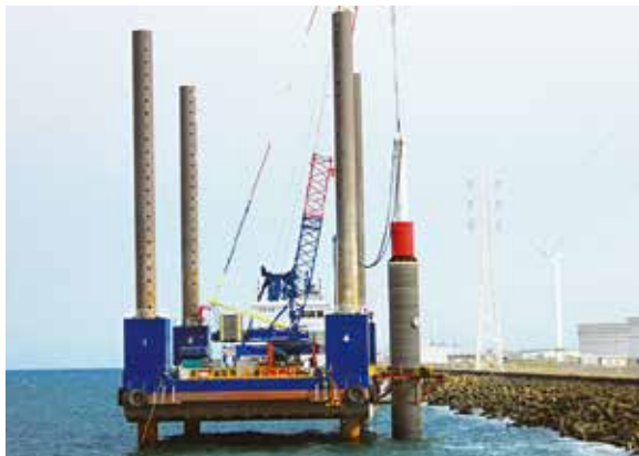
洋上風力発電事業 SEPにてモノパイル打設を行う 茨城県：神栖沖
