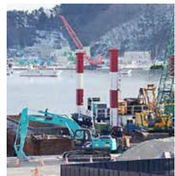
スパット台船にて障害撤去置換実施 岩手県：宮古港
