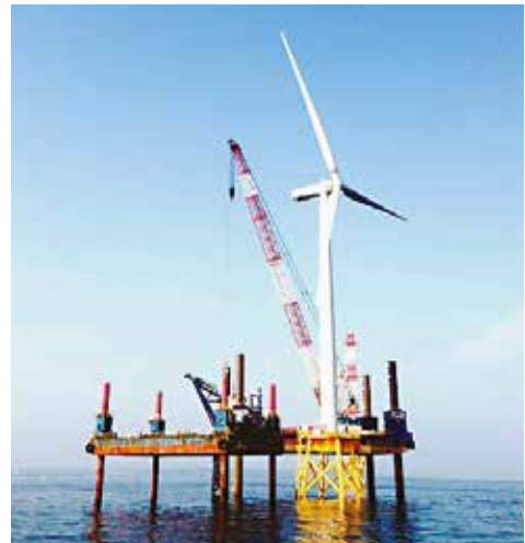
洋上風力発電事業 SEPにて風車据付を行う 福岡県：響灘沖
