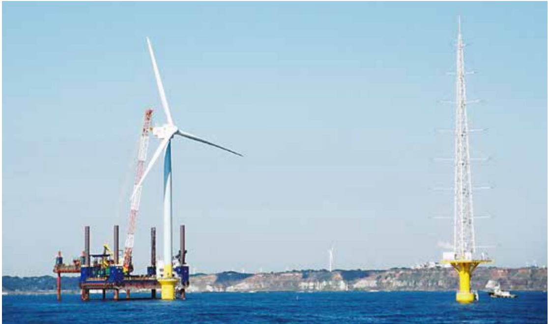
洋上風力発電事業 SEPにて風車・観測塔据付を行う 千葉県：銚子沖
