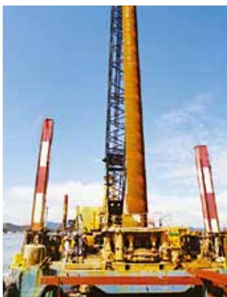
スパット台船にて鋼管杭を打設 岡山県：直島
