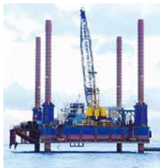
SEPにて既設鋼管杭を撤去 宮城県：鳥の海
