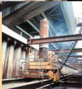
縮切内軽量架台での施工
