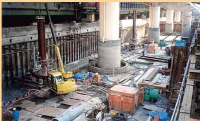
既設橋脚への近接施工
