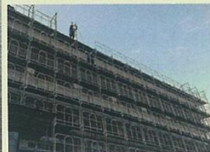
▲ 大規模な改修建築工事
