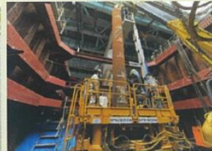
▲ 保有する杭打設置装置の一例
