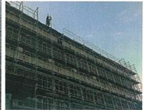
▲大規模な改修建築工事
