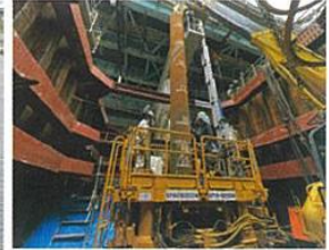
▲保有する杭打設装置の一例
